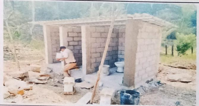
Foto 4: proceso de levantado de pared, techado e instalacion de inodoro del baño, modulo IV.
